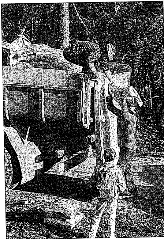
So wird hier Zement abgeladen
